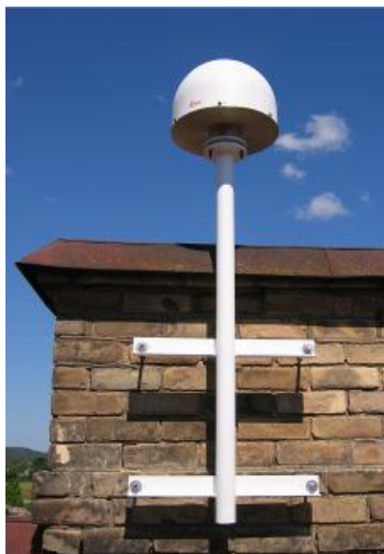
6. att. Antenas stiprinājums Madonas bāzes stacijā
