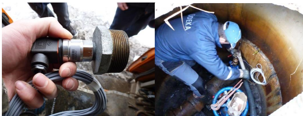
5.16. att. Ūdens spiediena mērītāja uzstādīšana ūdensvada akā
