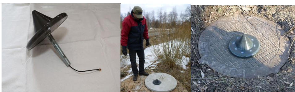
5.15.att. 868MHz \frac{1}{4} viļņu antenas uzstādīšana ūdensvada akas vākā
