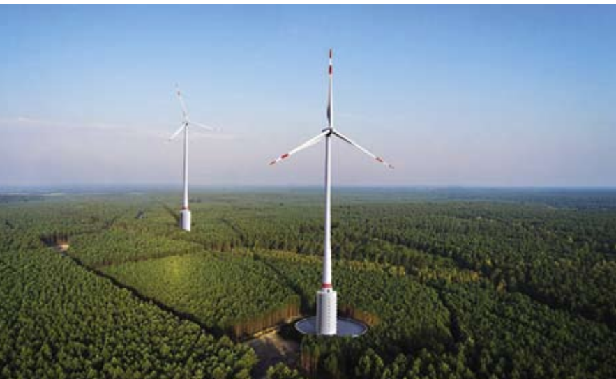
2. attēls. Vēja turbīna ar hidroakumulācijas augšējo rezervuāru tās mastā.
