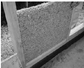
4.att. Kaņepes kā siltumizolācijas materiāls [10]
