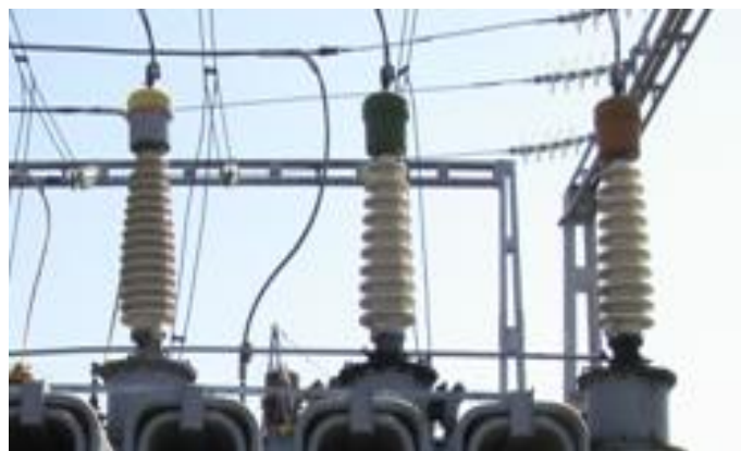
2. att. Nehermētiskie 110 kV caurvadizolatori.
