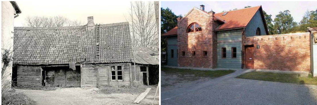
3.1.43. un 3.1.44. att. Ēka Skolas 6 pirms pārbūves 1992. g. [266] un pēc pārbūves 2009. g. [267]
