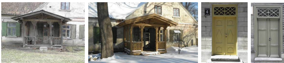
2.1.3.7. un 2.1.3.8. att. Vēsturiskas ēkas „pērle” – koka lievenis pirms un pēc restaurācijas 2009. g. 2.1.3.9. un 2.1.3.10. att. 2009. gadā restaurēti durvju komplekti J. Alunāna ielā 4 un 1905. gada ielā 12.
