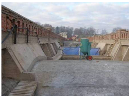
1.2.121. un 1.2.122. att. Ķieģeļu velvju tilta rekonstrukcija 2007. gadā – atsegtas tilta velves. [288] un tilts pēc rekonstrukcijas, kas pabeigta 2008. gadā
