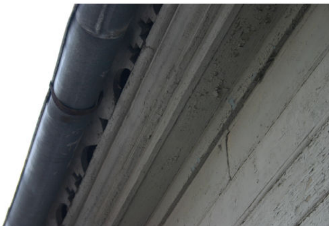
1905_gada_1_62010060039001_dzega1 Vēsturiska dēļu dzega un kokā griezts aizsegdēlis.
