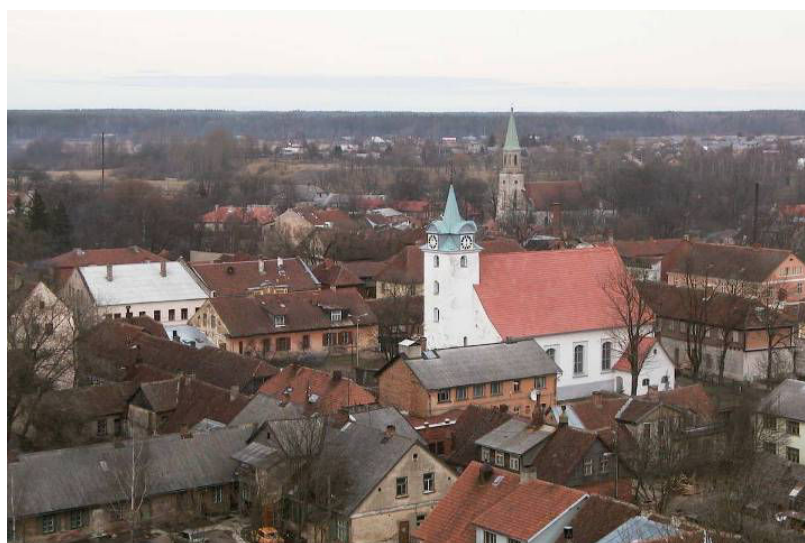
3.1.27. att. Kuldīgas vecpilsētas jumtu ainavā pārsvarā dominē amatnieciski darinātu Sarkano kārniņu jumti, bet redzami arī azbestcimenta segumi. Skats no Annas baznīcas torņa
