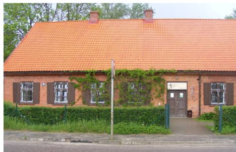
3.3.7. att. saskaņā ar 2002. g. apbūves noteikumu prasībām atjaunota ēka Jelgavas ielā,
