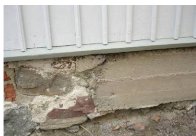
2.1.1.10. un 2.1.1.11. att. Laukakmeņu pamatu remonts ar cementa javu. Neatbilstošas tonalitātes – rozā, granīta flīzes ietvēs
