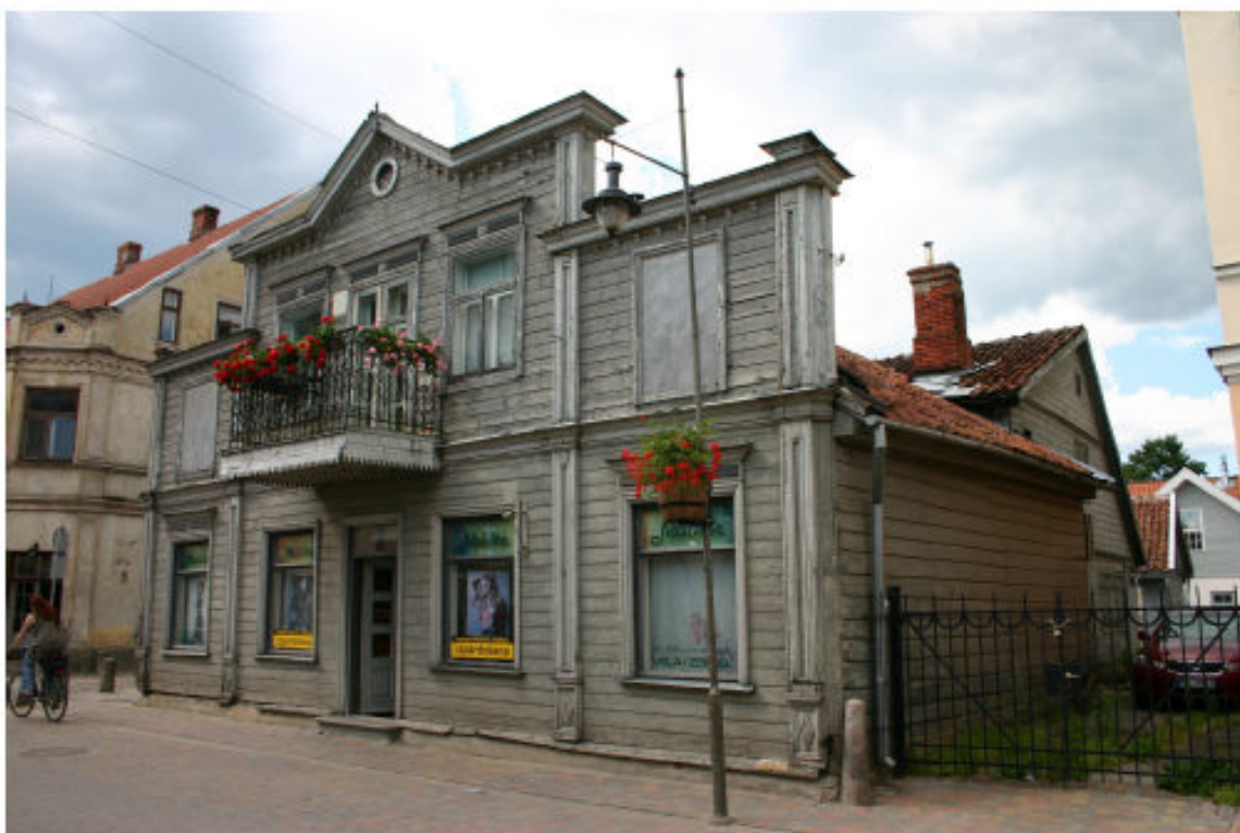
1905_gada_1_62010060039001_fasade1 Skats uz ēku no dienvidaustrumiem.
