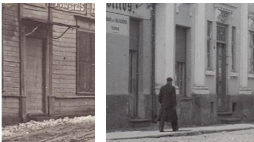
1.3.19. un 1.3.20. att. Uzjumtenis uz konsolēm Kalna ielā 22 [305] un pakāpieni pie ēkas Baznīcas ielā 14 [290], iedziļināti ailē un ar noapaļotiem stūriem.
