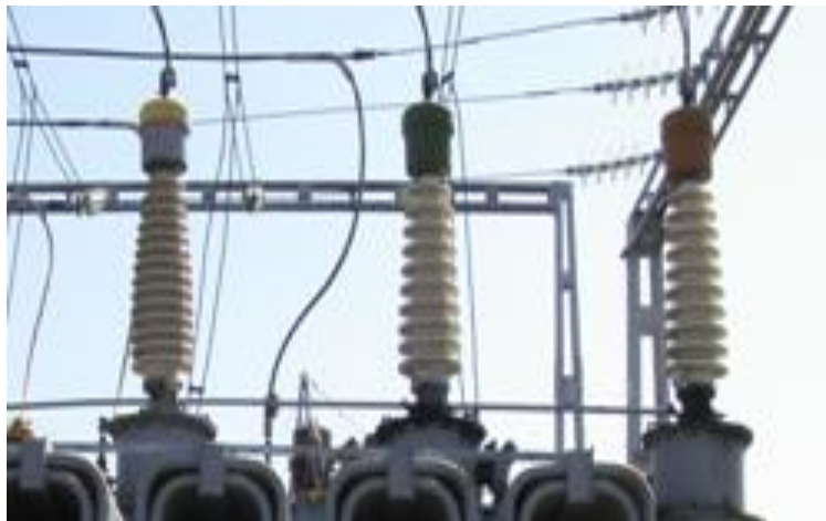
1.15. att. Nehermētiskie 110 kV caurvadizolatori
