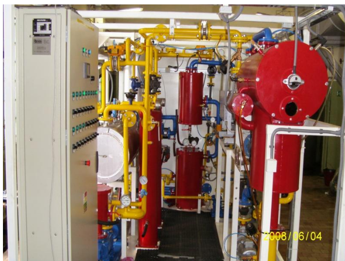
1.14. att. Eļļas reģenerācijas stacionārā iekārta
