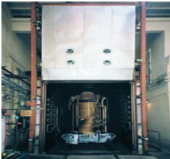
1.17. att. Transformatora tinumu mazgāšana un žāvēšana
