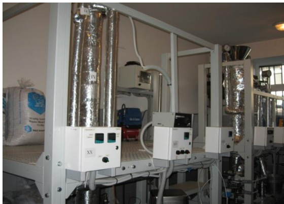
9. att. Oriģinālā pilotiekārtas
