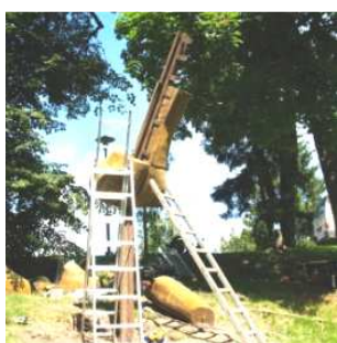
4.65.att. Skulptūras detaļu montāža uz nesošās konstrukcijas, autora foto
