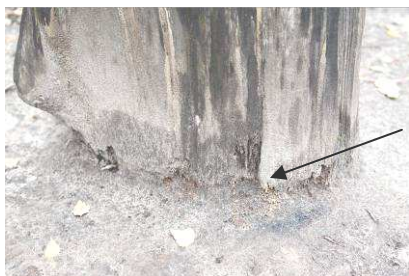
3.50.att. Mežainā apvidū uz zemes novietota objekta pamatne pēc pieciem ar pusi gadiem, autora foto
