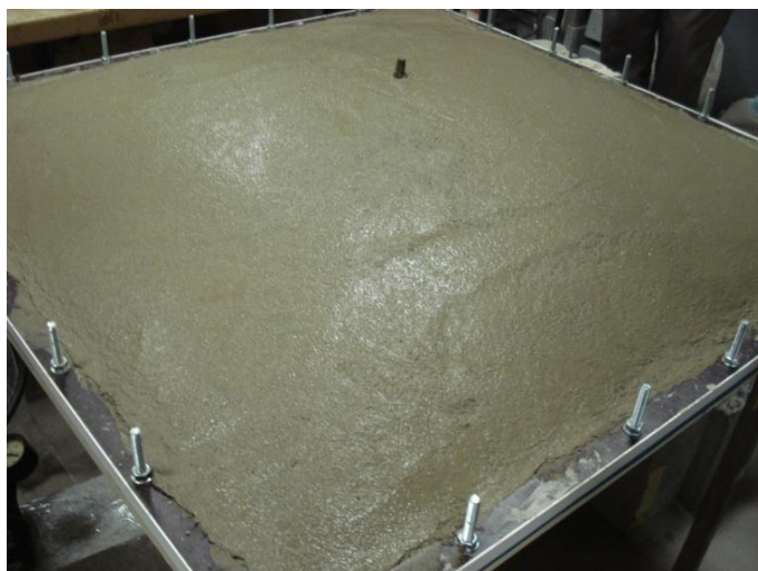
22. att. Čaulu izveidošanas tehnoloģiskais process izmantojot pneimatisko veidni
