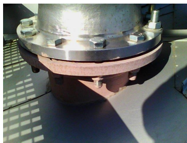
4.3.4.att. Vakuumvārsta pieslēguma atloka konstatētais termiskais tilts.
