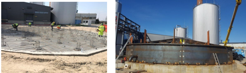
4. 1. att. Siltuma akumulatora pamata armēšanas darbi un metāla konstrukciju montāža (autora fotoattēli).
