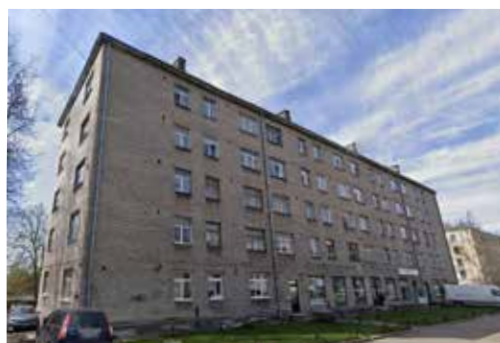
37. attēls. Tipveida projekta 1-430. sērijas piecstāvu dzīvojamā ēka ar veikalu Rīgā, Latgales ielā 188 ( GoogleMaps ).
