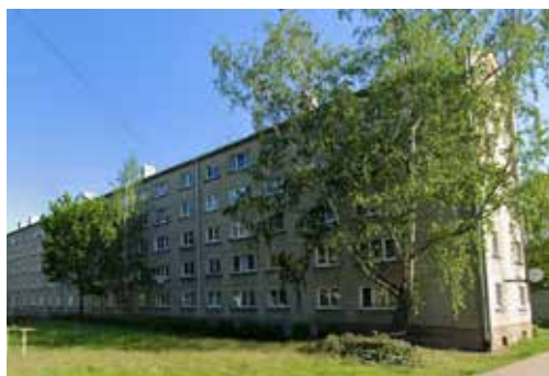
38. attēls. Tipveida projekta 1-430. sērijas piecstāvu dzīvojamā ēka Rīgā, Patversmes ielā 30 ( GoogleMaps ).
