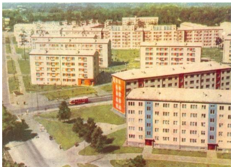
54. attēls. Ēkas ar mākslinieku darbnīcām Āgenskalna priedēs (20. gadsimta 60. gadi).
