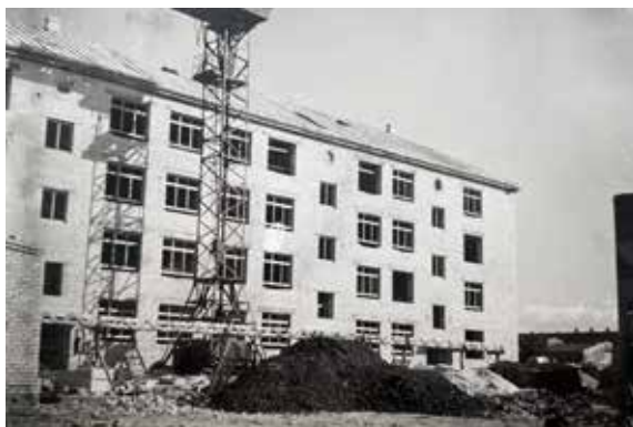
31. attēls. Tipveida projekta 1-430. sērijas dzīvojamās ēkas būvniecība Liepājā, Brīvības ielā (1956).
