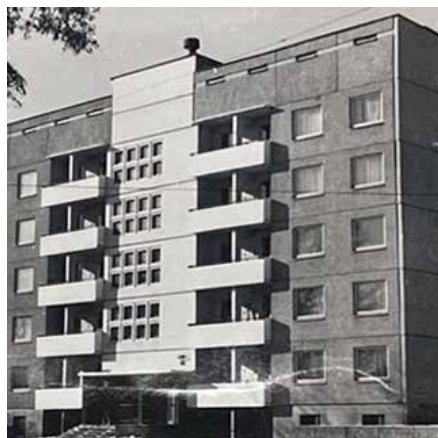
102. attēls. Tipveida projekta 119. sērijas piecstāvu eksperimentālā ēka Ilģuciemā, V. Tereškovas (tagad Buļļu) ielā (20. gadsimta 70. gadi).
